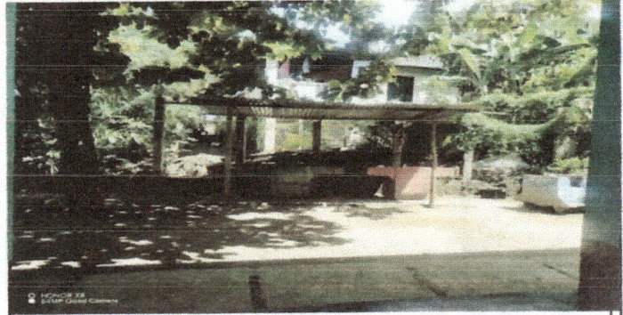
Galera informal de pilas, improvisadas y deterioradas
